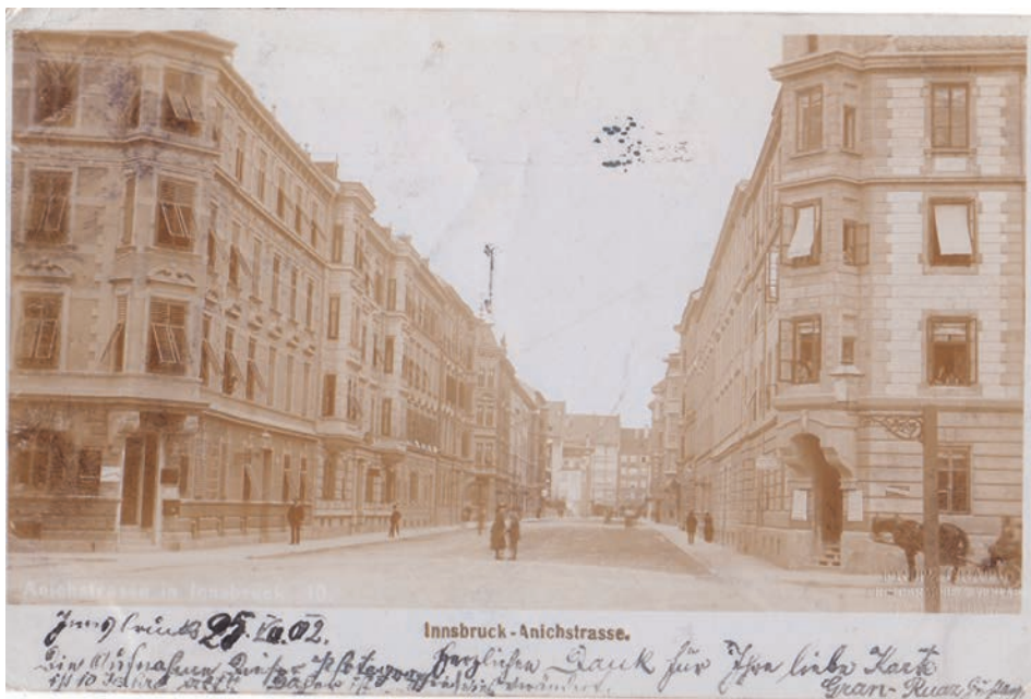
Abb. 1 – Ein Blick in die noch junge Anichstraße Richtung Maria-Theresien-Straße. Am Ende links ist noch das sog. Stembergerhaus zu erkennen.
